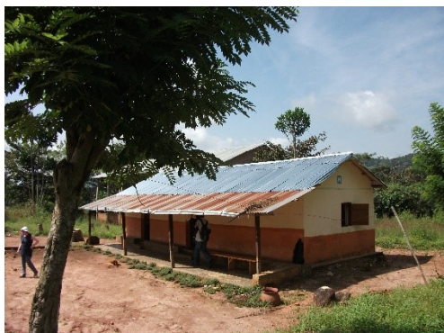
Sodo Todji: Case de Santé, renoviert 2010
